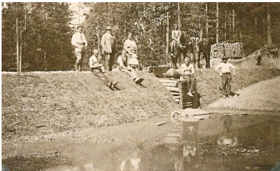
dokončení hráze Petrovky, o její vybudování se zasloužil lesník Novotný
